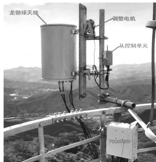
图 4 远程天线控制系统现场实拍图
